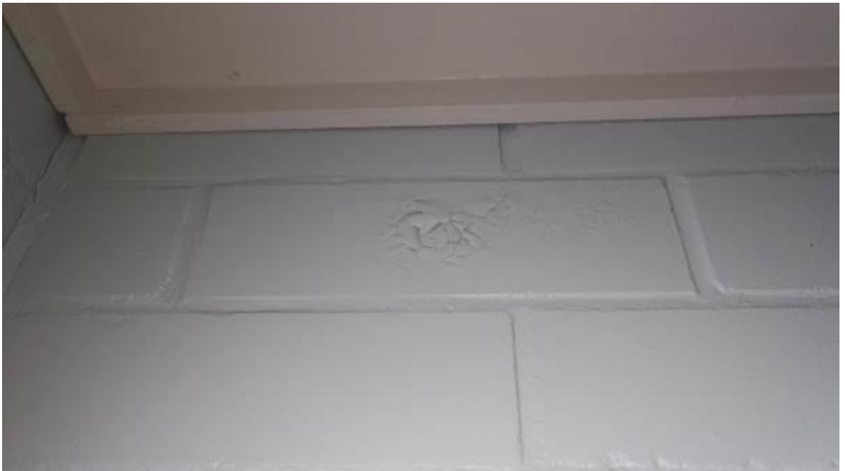
Kuva 6.6.14. Näyte M18, liikuntasali, opettajien pukuhuone, tiiliväliseinän maalipinta ja laasti.
