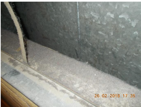
Kuva 9.11. Liikuntasalin ilmanvaihtokanavat olivat likaiset ja ne tulee puhdistaa.
