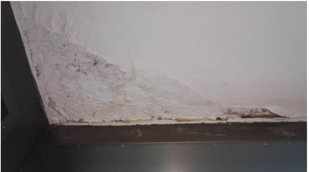
Kuva 6.6.12. Näyte M16, 1. kerroksen aula, sisäkaton maalipinta ja tasoite ja ulkoseinän polyuretaanieriste.
