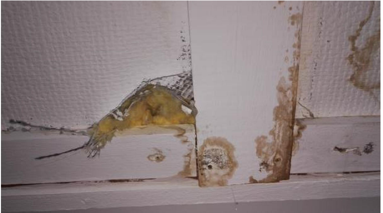
Kuva 6.6.13. Näyte M17, 1. kerroksen aula, sisäkaton akustolevy.
