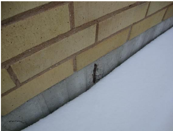
Kuva 4.4.3. Sokkelin rakenneteräkset ovat ruosteessa ja rapauttavat betonia.
