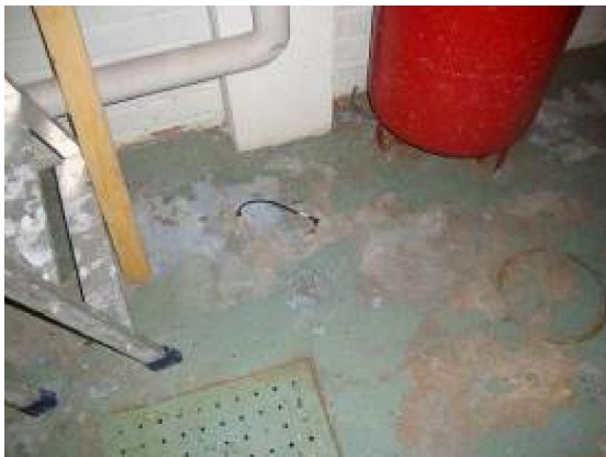
MP5, kellarikerros, lämmönjakohuone
