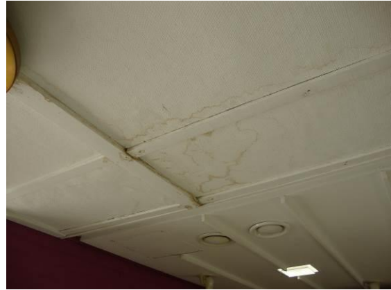
Kuva 4.6.8. Aulan katossa on korjaamatta vanhan vesivuodon jälkiä.
