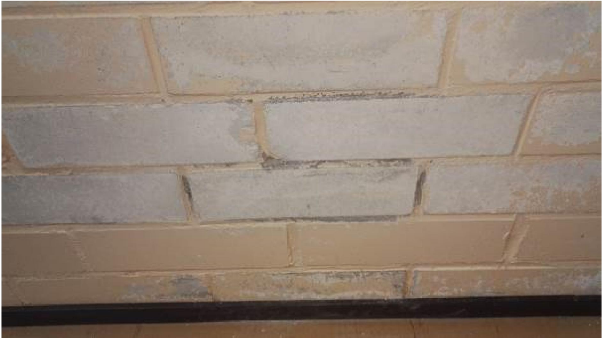
Kuva 6.6.15. Näyte M19, liikuntasali, tyttöjen pukuhuone, tiiliväliseinän maalipinta ja laasti.
