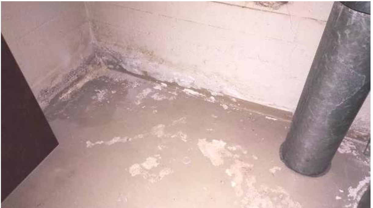
Kuva 6.6.8. Näyte M11, väestönsuojatila, ulkoseinän sisäpintoite, maali ja tasoite.
