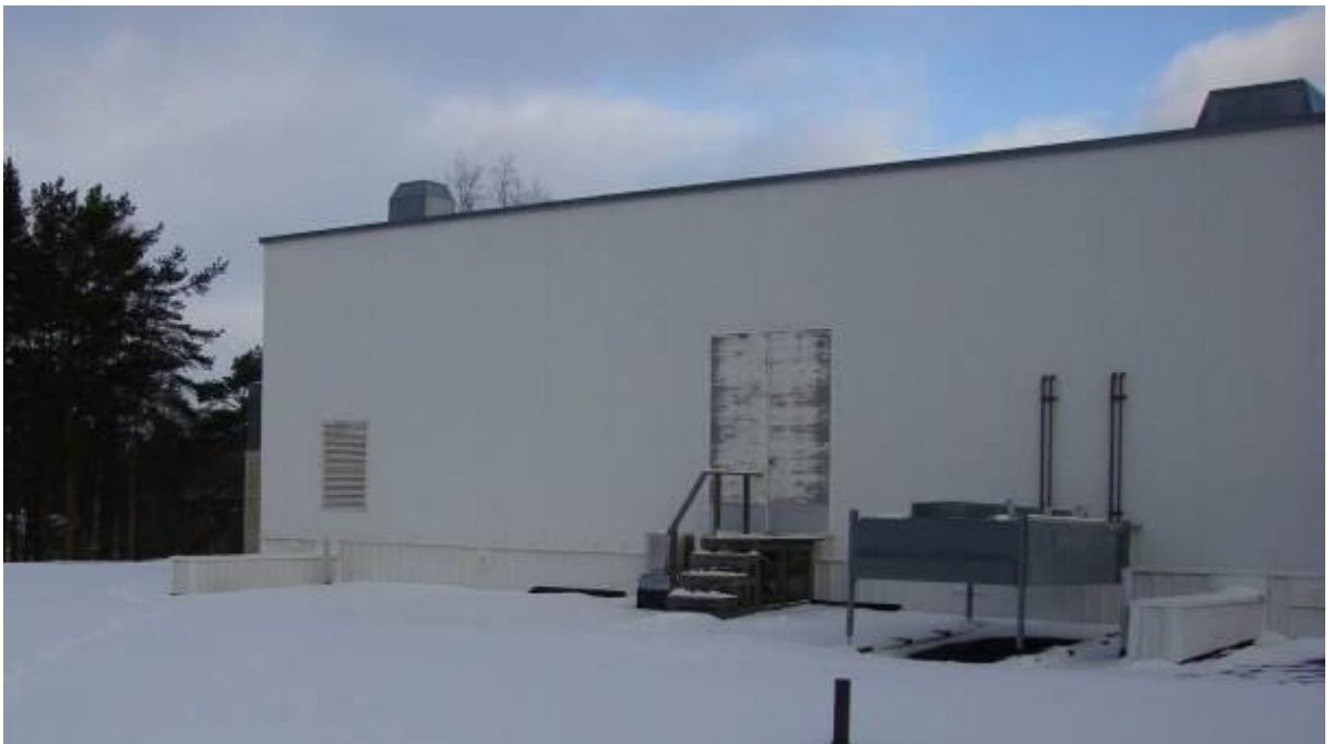
Kuva 7.8.2.18. Näyte 20, IV-konehuoneen ulkoseinän maali.
