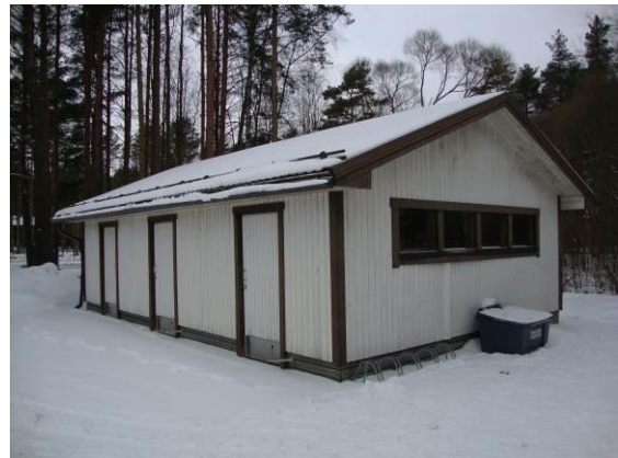
Kuva 4.1.8. Pihavarasto on siisti ja hyväkuntoinen.
