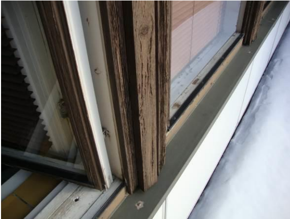
Kuva 4.5.3. Ikkunoiden kunnostuksen/uusinnan yhteydessä myös ikkunoihin liittyvät paneelit on uusittava.
