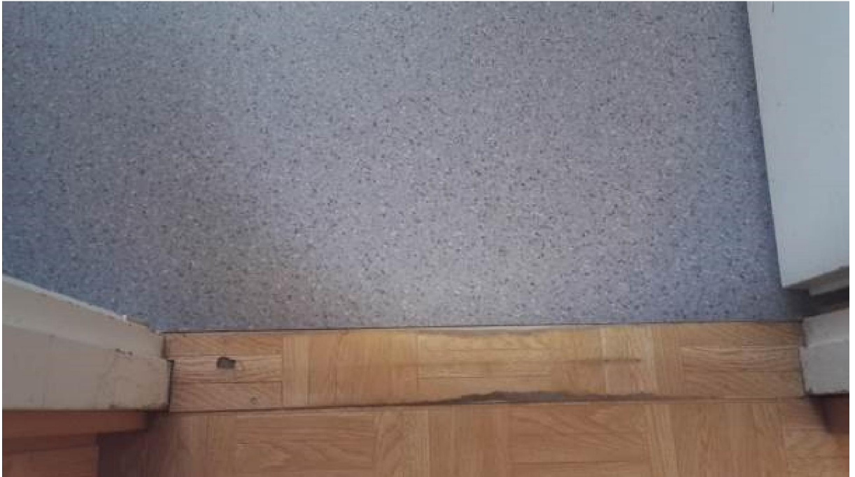
Kuva 7.8.2.20. Näyte 32A, talonmiehen asunnon linoleum-matto, liima ja tasoite.
