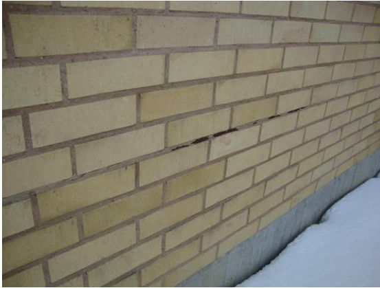
Kuva 4.4.5. Tiilimuurauksen ruostunut vaakateräs on rapauttanut tiilisaumausta.
