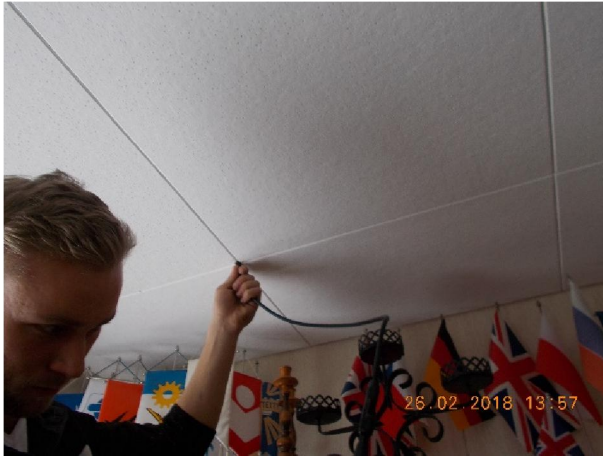
Kuva 9.12. Alaslaskettujen kattolevyjen välitila oli tarkastushetkellä hyväkuntoinen.
