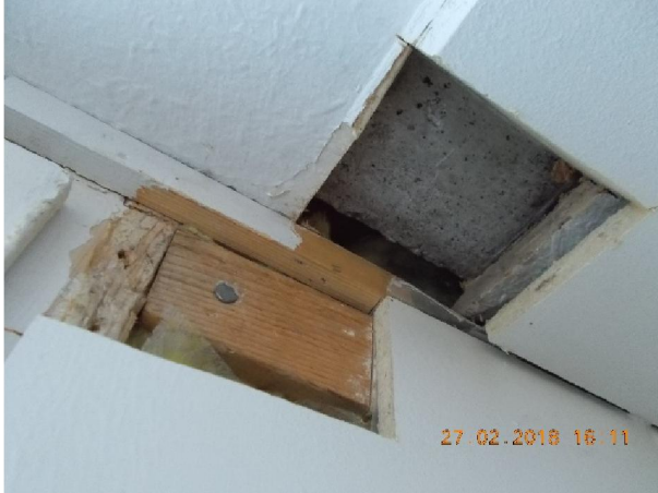
Kuva 9.6. Rakenteiden sisälle jätettyihin eristeilleihin ja levyrakenteisiin on jäänyt jälkiä vaurioista.
