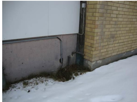
Kuva 4.1.6. Heinittynyttä sokkelin vierustaa.
