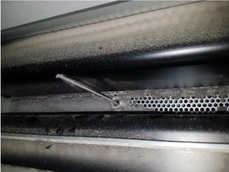
Kuva 11.3.4. Poistventtiilit likaisia, melkein tukossa.
