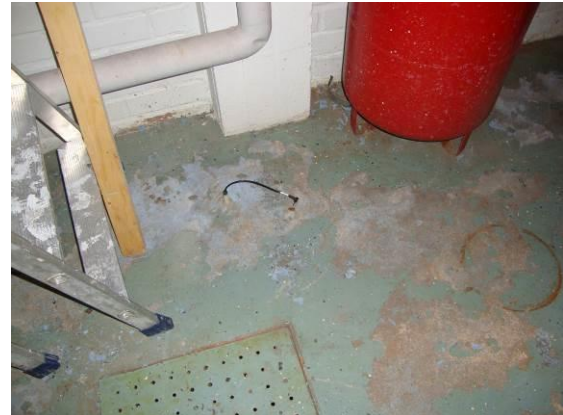
Kuva 4.2.2. Lämmönjakuhuoneen lattian maalipinnoite hilseilee maakosteuden vaikutuksesta.
