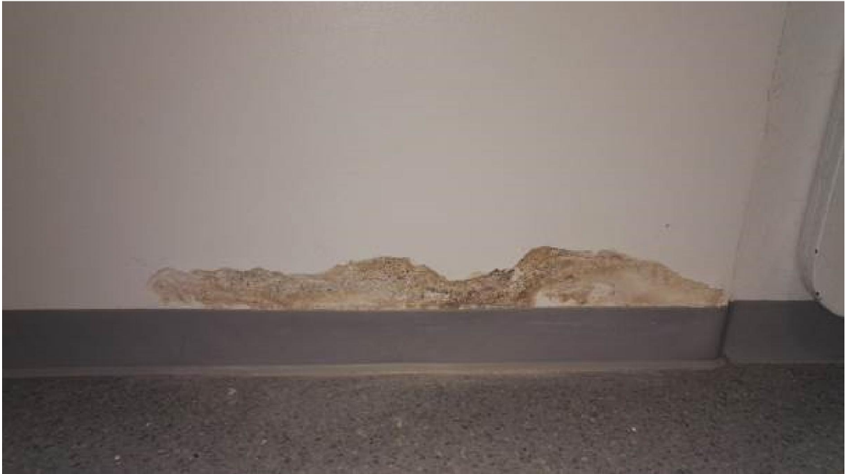
Kuva 6.6.9. Näyte M12, kellarikäytävä, väestönsuojatilan sisäänkäynti, väliseinän maali- pinta ja tasoite.
