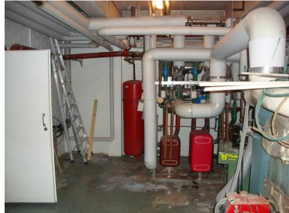
Kuva 4.6.14. Pohjakerroksen lämmönjakohuoneen lattiamaali on hilseillyt pahoin todennäköisesti maakosteuden vaikutuksesta.
