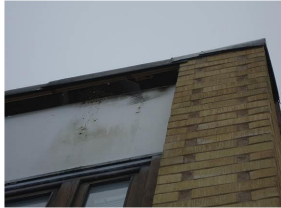
Kuva 4.4.6. Lintujen pääsy ullakolle on estetty räystäällä suojaverkoin. Paikoin verkko on jostain syystä irronnut kiinnityksistään.
