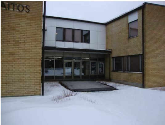
Kuva 4.5.5. Teräsrakenteiset ovet ja ikkunat pääsisäänkäynnissä.
