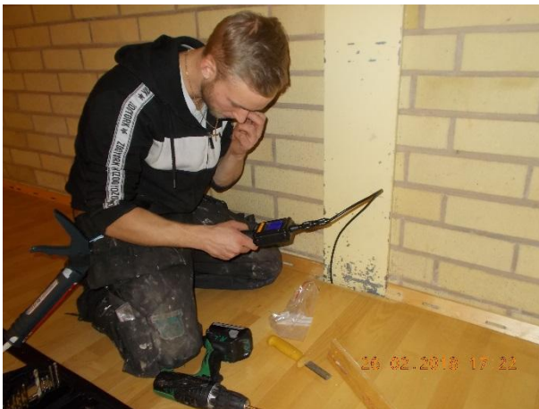
Kuva 9.7. Liikuntasalin alapohjassa oli havaittavissa pieniä viitteitä vauriosta.
