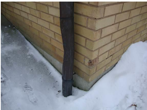
Kuva 4.3.9. Lommoutunut syöksytorvi.
