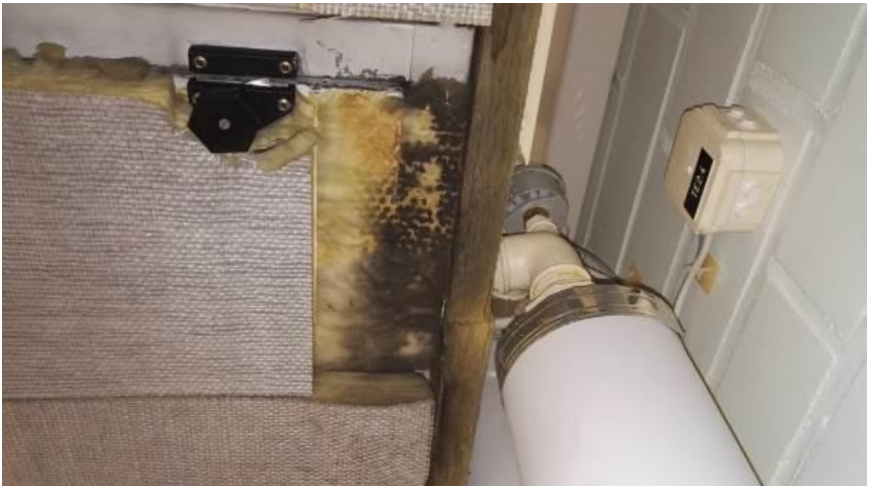
Kuva 6.6.16. Näyte M20, liikuntasalin varastohuone, IV-kanavan eristevilla. Tummentumat eristevillassa ovat ilmavuotojälkiä.
