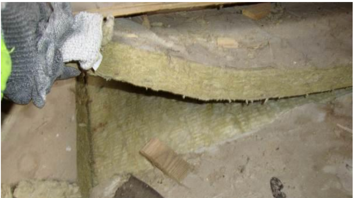
Kuva 6.6.4. Näyte M5, liikuntasalin yläpohja, eristevilla.
