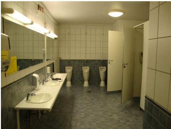
Kuva 4.6.9. Wc-tiloja. Tiloissa ei havaittu pintamittauksin poikkeavia kosteustilanteita. Maanvaraisen lattiapinnan kosteusarvot ovat jonkin verran koholla.
