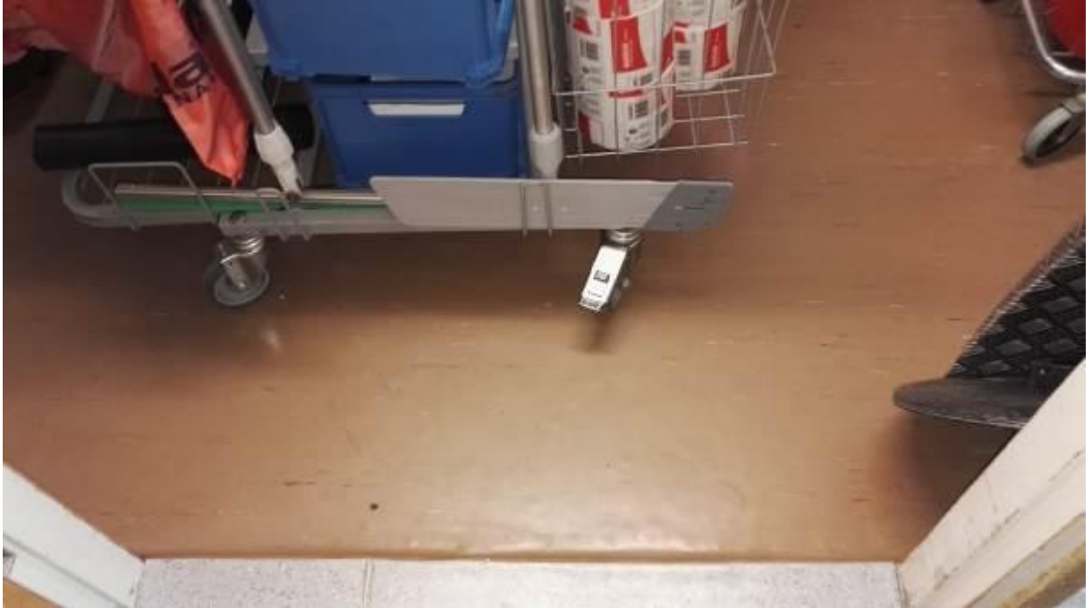
Kuva 7.8.2.7. Näytettä 9 vastaavaa ruskeaa muovimattoa.
