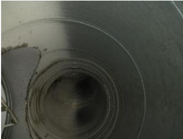
Kuva 9.4. Vähäistä pölyä ilmanvaihtoputkistossa.
