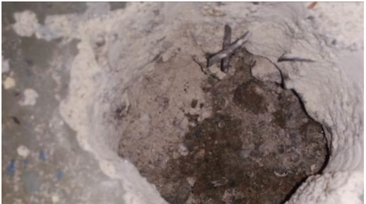
Kuva 7.8.2.1. Näyte 1, Kellarin alapohja, bitumieriste.
