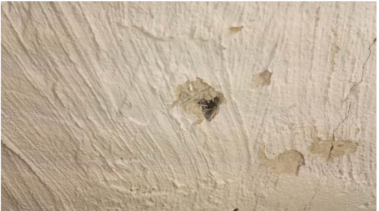
Kuva 6.6.6. Näyte M8, kellarin varastohuone, sisäkaton verhous, tojax-levy.
