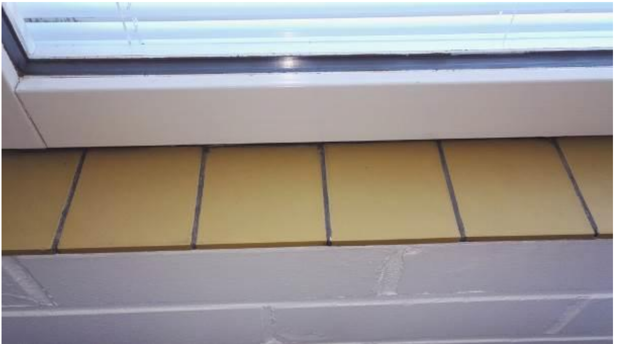
Kuva 7.8.2.6. Näyte 8, 2.krs luokka AT21, ikkunapulpetin keltainen laatoitus, saumausmassa ja tasoite.
