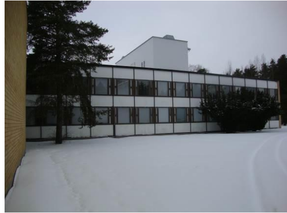
Kuva 4.1.4. Takasivulla puusto ja pensastutukset ovat lähes kiinni rakennuksessa.
