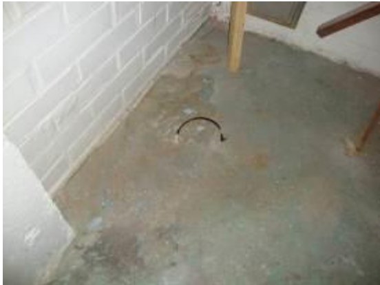
MP4, kellarikerros, lämmönjakohuone
