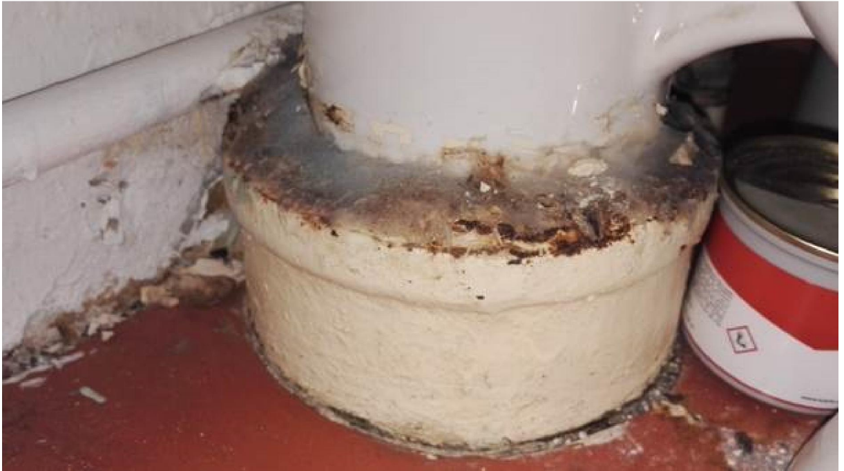
Kuva 6.6.19. Mikrobikasvustoa opettajainhuoneen wc-istuimen jalan ja viemäriputken liittytäkohdassa.
