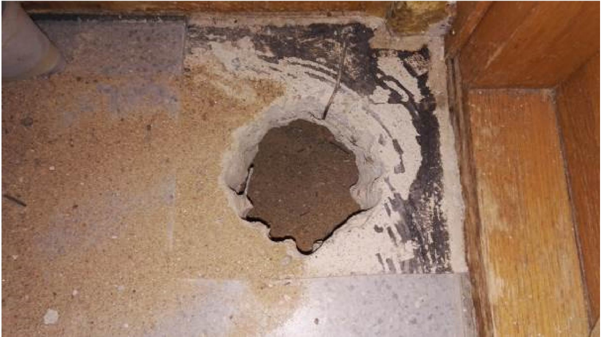
Kuva 6.6.3. Näyte M4, 1. kerros, maanvarainen betonilaatta.
