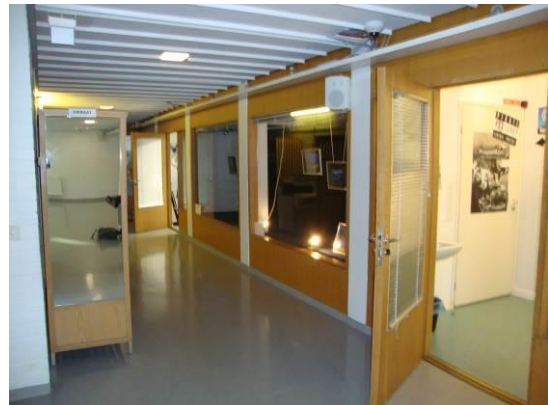
Kuva 4.5.6. Sisätilojen väliovet ovat hyvässä kunnossa.
