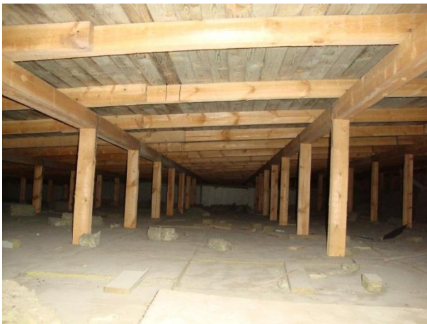
Kuva 9.10. Yleiskuvaa liikuntasalin yläpohjasta.
