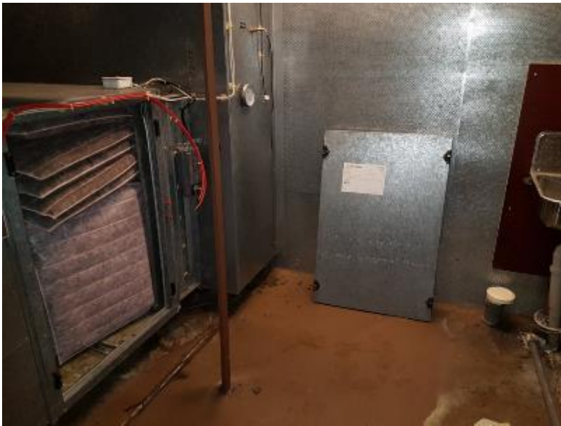
Kuva 11.3.2. Liikuntahallin tulokoneen suodatinluukku, luukku pois paikoiltaan.
