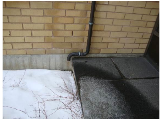
Kuva 4.3.8. Pääoven edustalla parvekkeen vedet on ohjattu portaiden pieleen.
