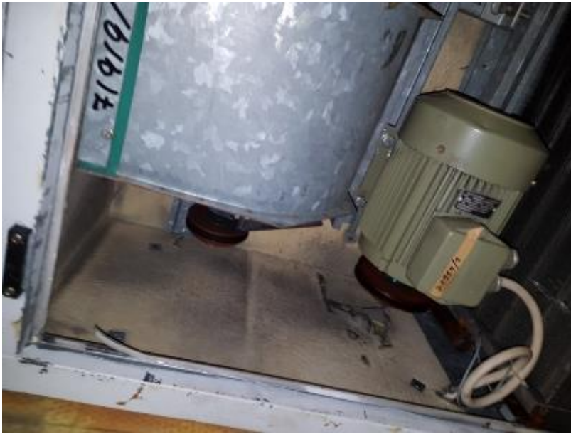
Kuva 11.3.1. Tk2 hihna poikki, kannakkeet pettäneet
