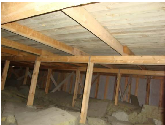
Kuva 4.3.3. Yläpohjan hyväkuntoisia puurakenteita.
