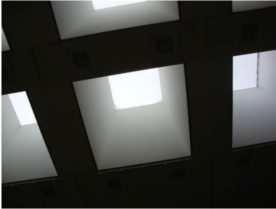
Kuva 4.6.7. Ruokalan kattoikkunoissa ei havaittu vesivuotoja. Kaksi ikkunakupua on uusittu todennäköisesti rikkoutumisten johdosta.
