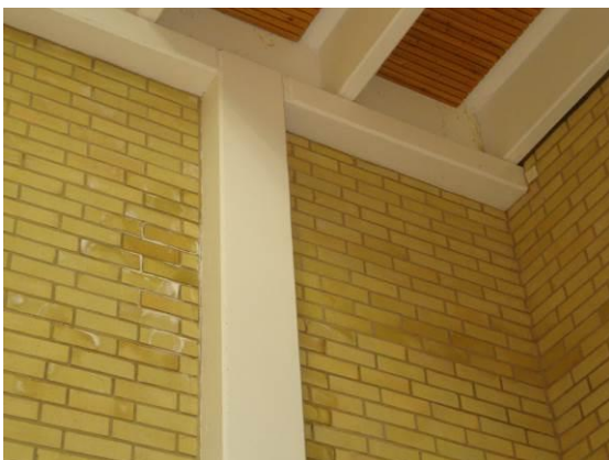
Kuva 4.6.11. Liikuntasalin seinissä on kalkkeumia ja tummumia, jotka viittaavat kosteusvaurioon.
