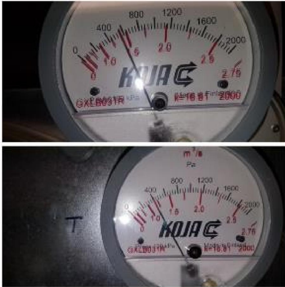
Kuva 11.3.5. Auditorion painemittarit, joista saatu ilmamäärät.
