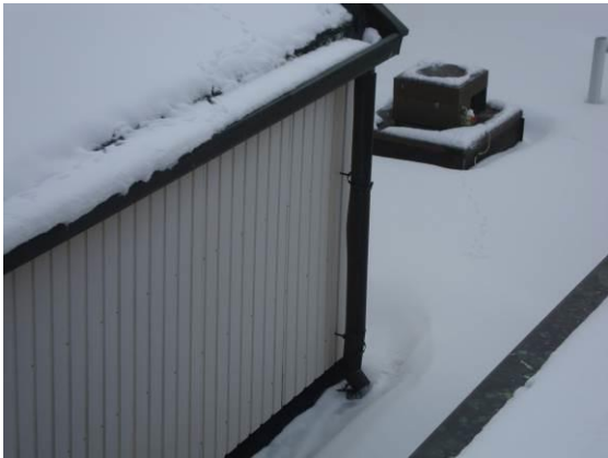
Kuva 4.3.7. Tukkeutunut, jäätynyt ja vaurioitunut syöksytorvi.
