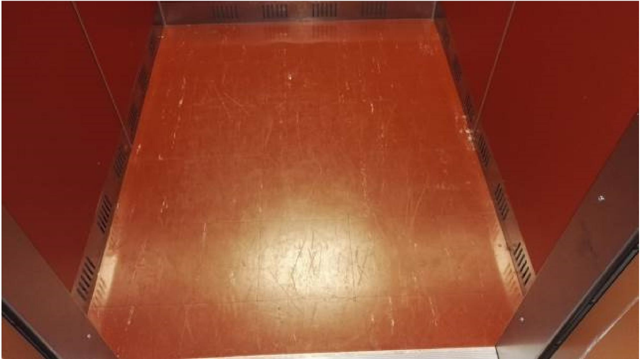
Kuva 7.8.2.17. Näyte 9, hissien lattian punainen vinyylilaatoitus ja liima.
