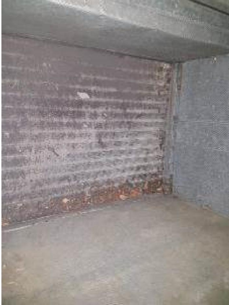
Kuva 11.3.3. Liikuntahallin tulokoneenilmanvaihtopatteri melkein tukossa.
