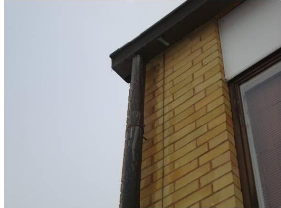
Kuva 4.3.6. Pääoven viereinen vesikouru ja syöksytorvi vuotavat vettä julkisivupinnalle.
