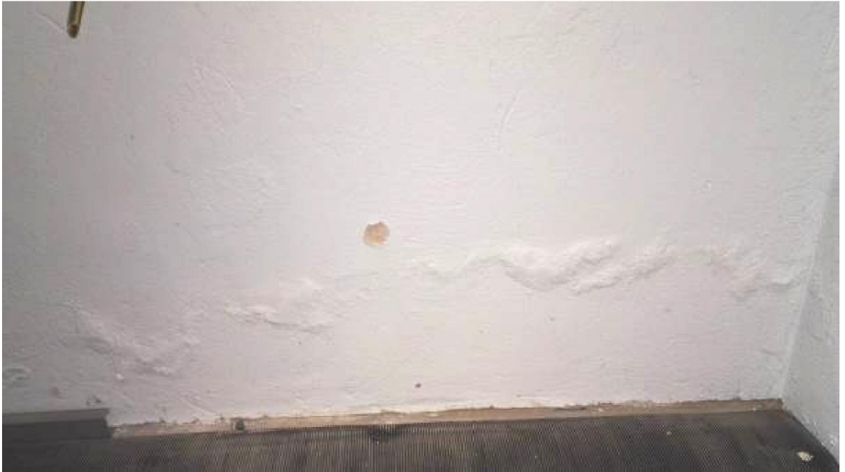
Kuva 6.6.7. Näyte M9, kellarin sähköpääkeskus, ulko- ja väliseinien maalipinta ja tasoite.
