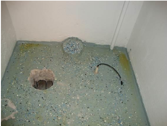
Kuva 4.2.1. Alapohjaan tehty rakenneavaus.
