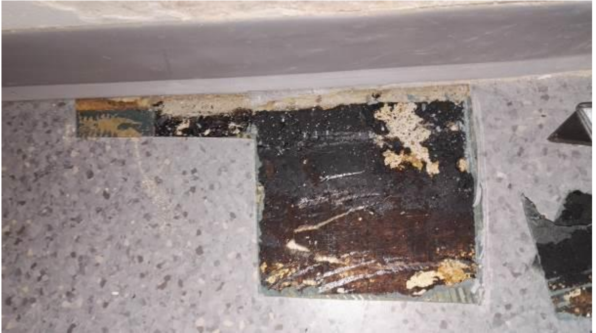
Kuva 6.6.17. Näyte M25, kellari, väestönsuojatilan sisäänkäynti, muovimatto ja liima.
