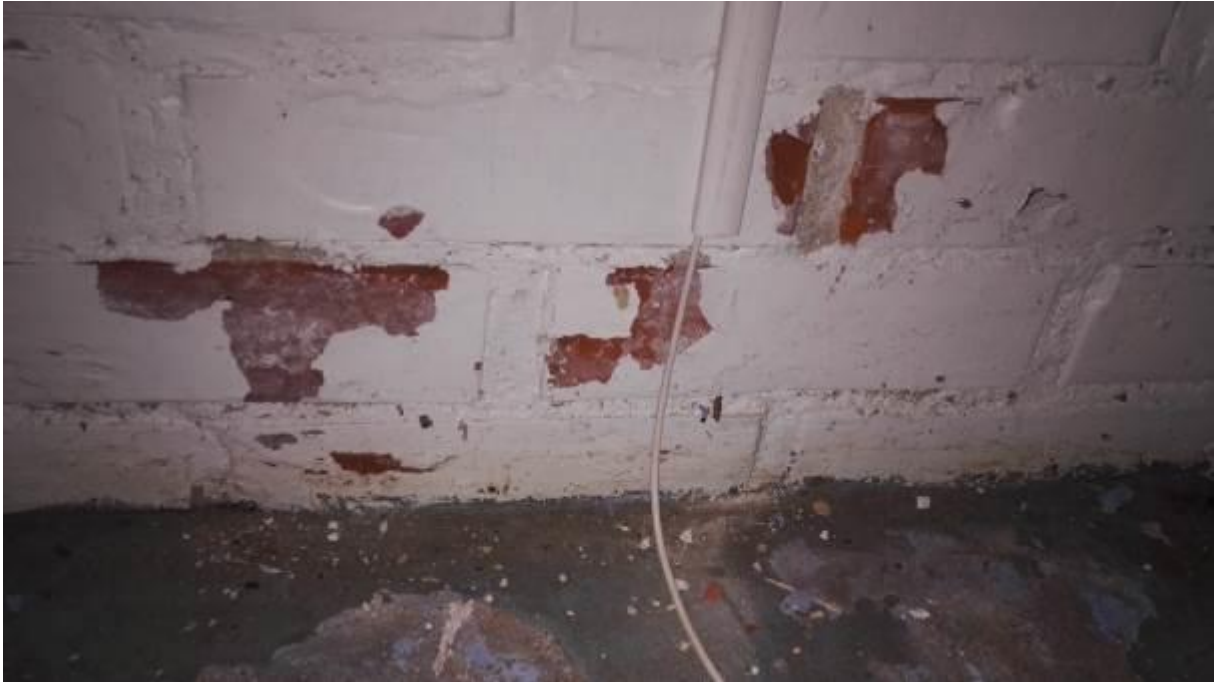
Kuva 6.6.1. Näyte M1, kellari, lämmönjakuhuone, väliseinän maalipinta, tiili ja laasti.
