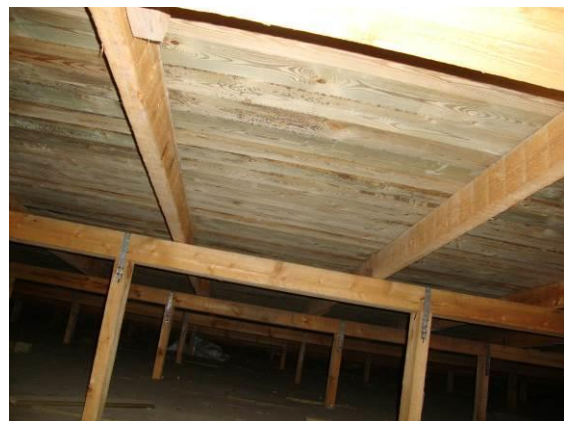
Kuva 4.3.4. Paikoitellen yläpohjassa on havaittavissa lievää mikrobikasvustoa.
