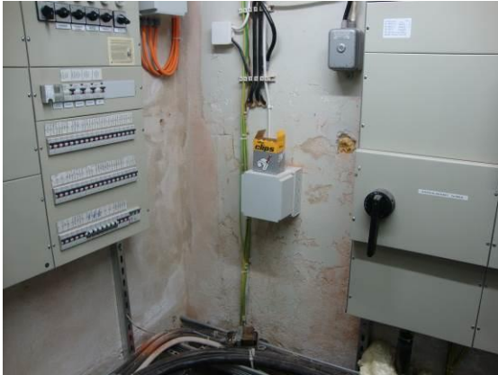
Kuva 4.6.13. Pohjakerroksen sähköpääkeskuksessa on sekä seinissä, että lattiasa kosteuden aiheuttamia vaurioita.
