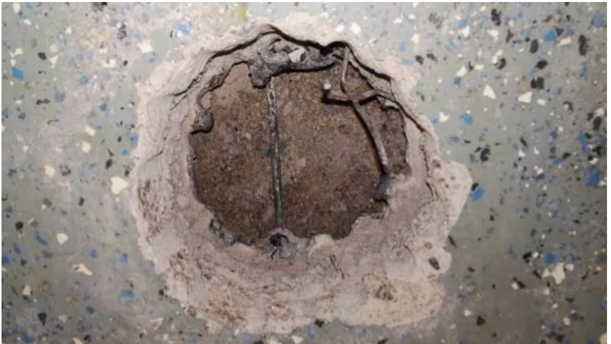
Kuva 6.6.2. Näyte M3, kellari, maanvarainen betonilaatta.
