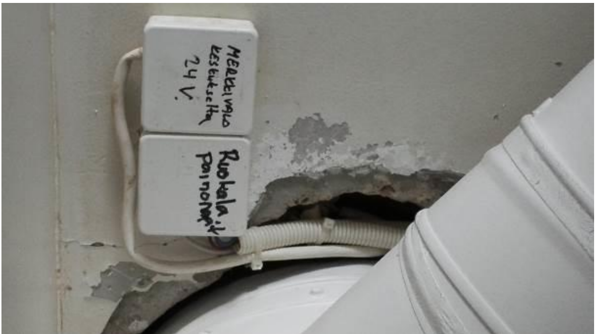
Kuva 6.6.10. Näyte M14, keittiö, sisäkaton maalipinta ja tasoite.
