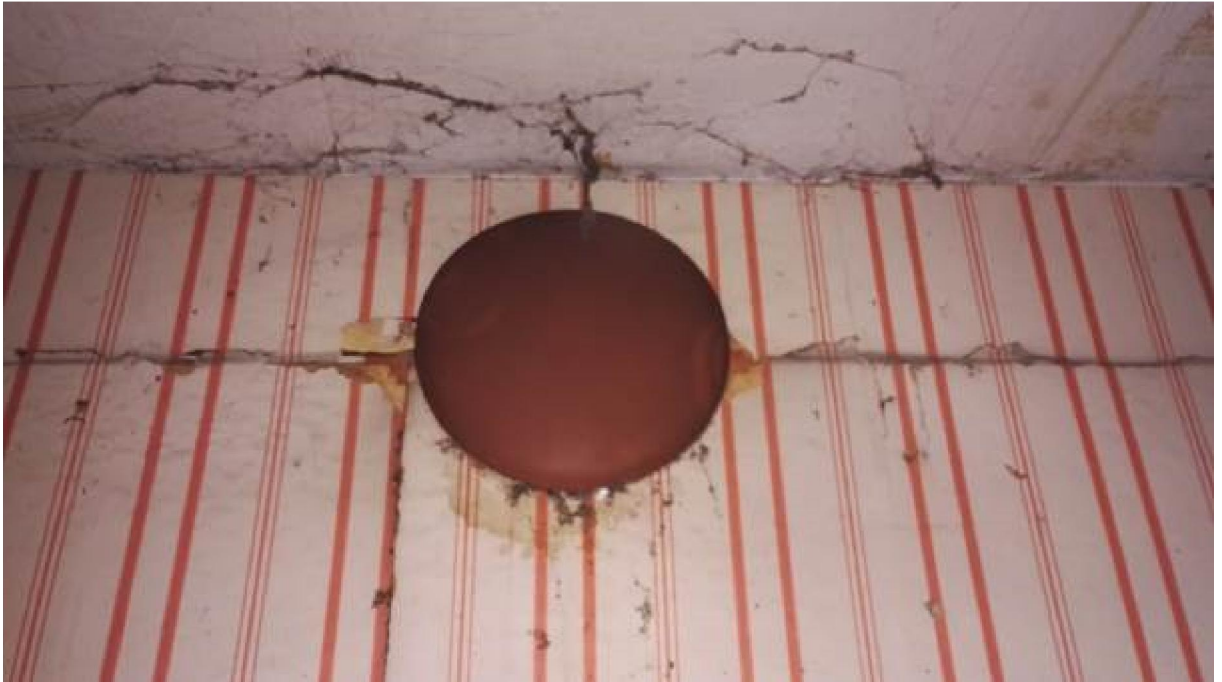
Kuva 6.6.5. Näyte M7, kellarin varastohuone, ulkoseinän sisäverhous, insuliittilevy.
