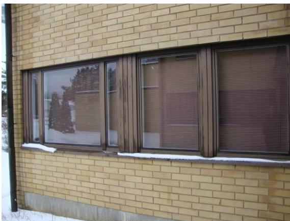
Kuva 4.5.1. Rakennuksen tyydyttävässä kunnossa olevia puuikkunoita.
