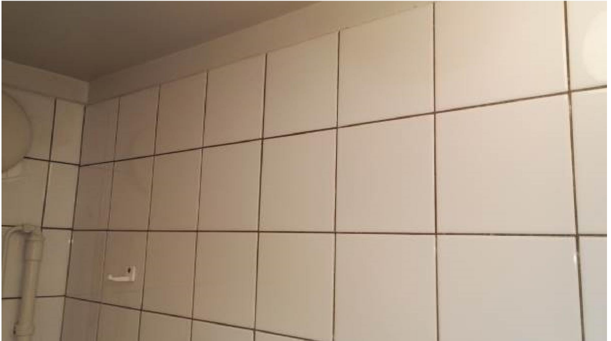
Kuva 7.8.2.8. Näytettä 10 vastaavaa valkoista seinälaatoitusta.
