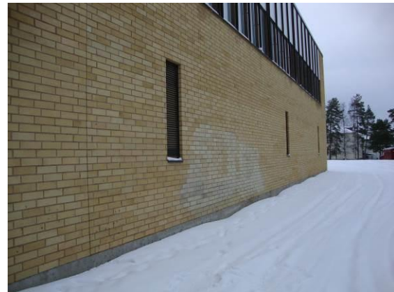
Kuva 4.4.4. Liikuntasalin seinässä mahdollinen kosteusvaurio. Tiilimuurauksesta puuttuvat tuuletusraot alimmasta tiilivarvistä.
