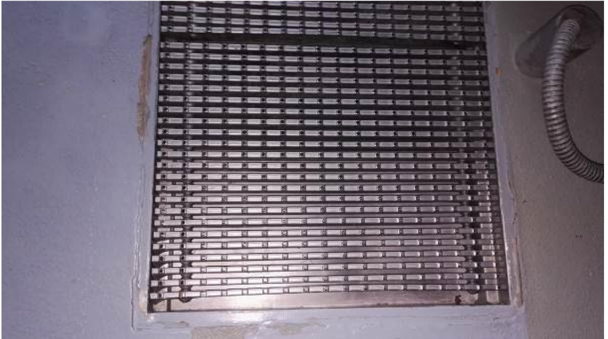
Kuva 6.6.11. Näyte M15, keittiö, lattian maalipinta ja tasoite.
