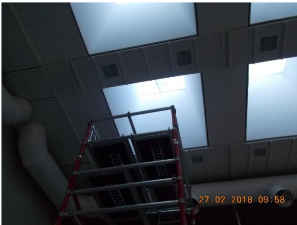
Kuva 9.13. Ruokasalin kattoikkunoiden levyrakenteissa oli havaittavissa vesivuotojälkiä.
