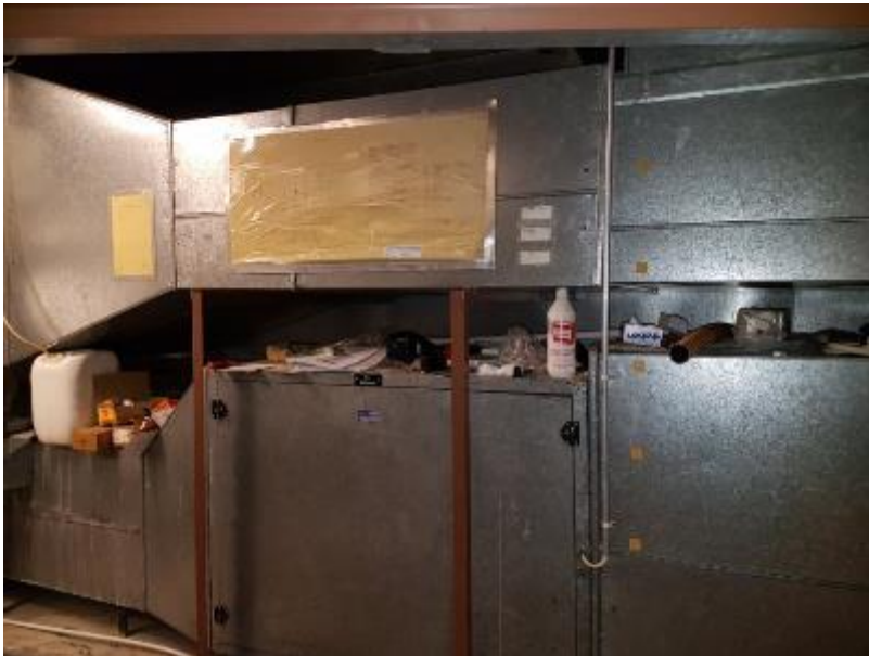
Kuva 11.3.6. Liikuntahallin poistokone pitää vinkuvaa ääntä.
