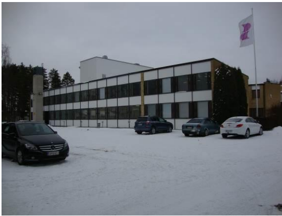
Kuva 4.4.1. Ikkunaseinän levyrakenteista julkisivua.
