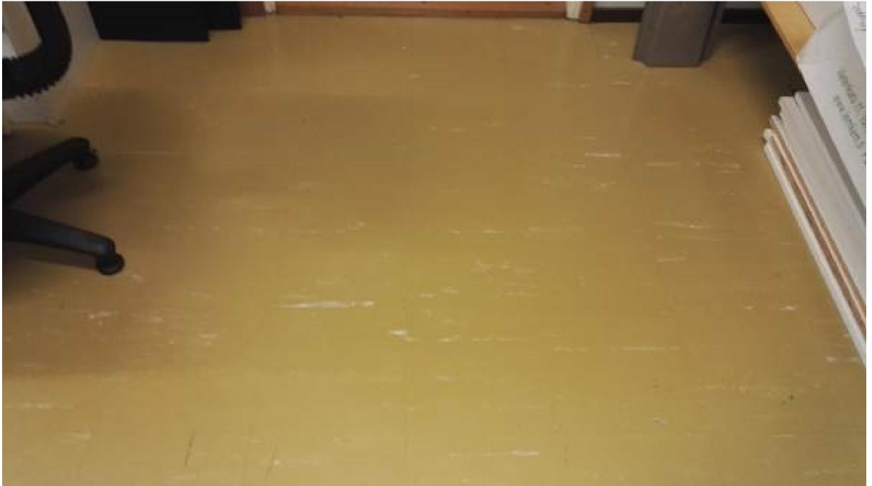
Kuva 7.8.2.5. Näytettä 7 vastaavaa keltaista vinyylilaatoitusta.
