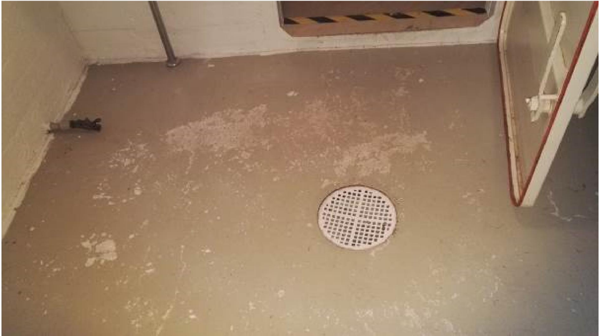
Kuva 7.8.2.16. Näyte 19, kellari, vss-tilan lattiamaali ja tasoite.
