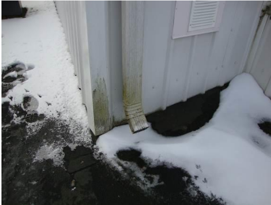
Kuva 4.3.5. IV-konehuoneen kattovedet on ohjattu rakennuksen tasakatolle. Vesi lammikoituu syöksytorven alle.
