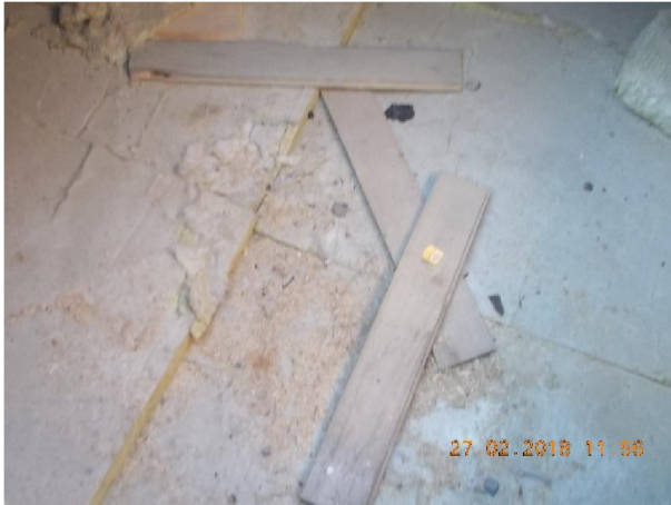
Kuva 9.9. Yläpohjaan jätettyä rakennusjätettä. Liikuntasalin ja päärakennuksen yläpohjan villoista löytyi jälkiä kosteusvauriosta.
